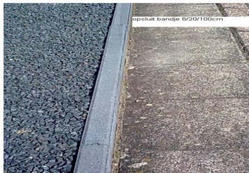
Nr 6: Opsluitband Opsluitband 6x20 cm
