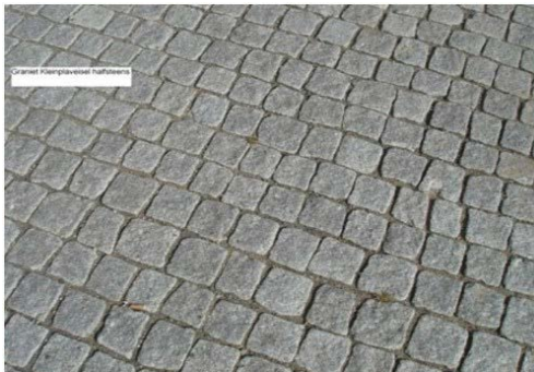
Nr 12: Bestrating type 3 Kleinplaveisel
