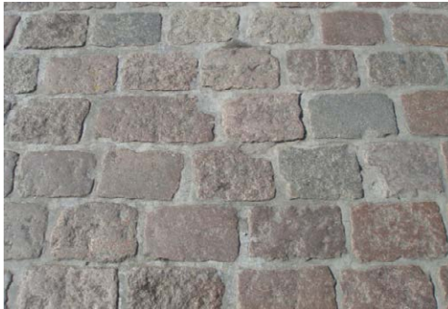
Nr 12+13: Bestrating type 3 Zweedsgraniet in gebonden voegvulling
