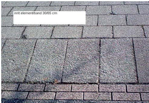
Nr 5: Trottoirband Inritblok
